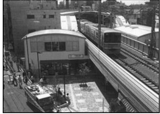
B 駅工事後
