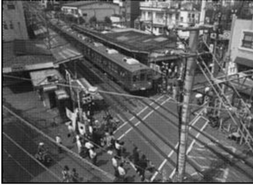
B 駅工事前
